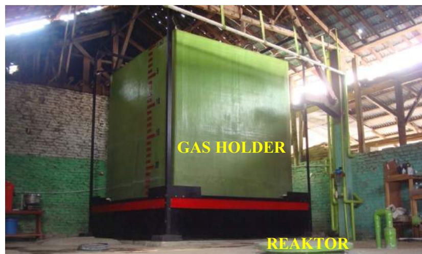
Gambar 4.14. Pengolahan limbah tahu dengan reaktor anaerobik tipe Fixed Bed di CV. Promatun Aroyyan
