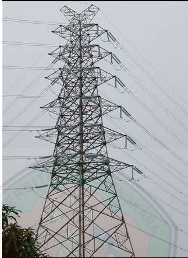
Gambar 1. Contoh salah satu tower Saluran Udara Tegangan Tinggi 150 kV Cikarang - MM2100
