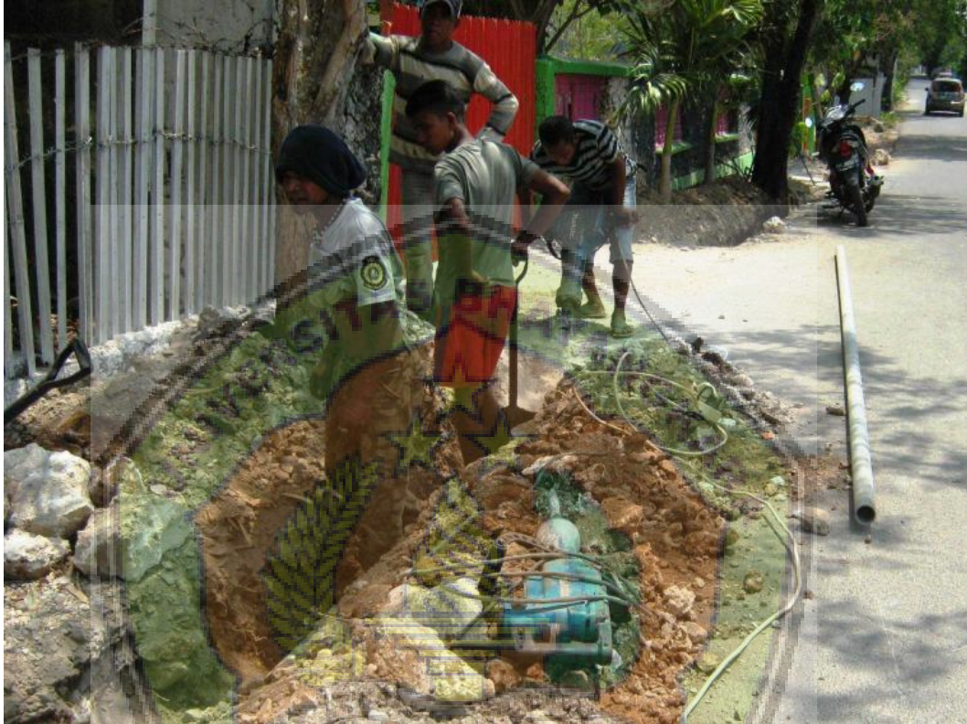
Gambar 1.2 Proses penghancuran batu dengan Jack Hammer
