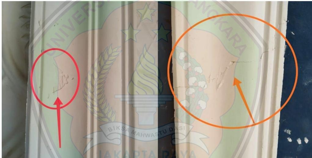
**Gambar 1.2** Gompalan dan Patahan pada *Lis gypsum*
