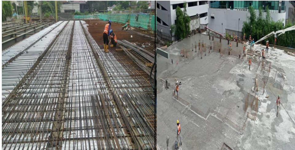
Gambar 1.3 Pemasangan Besi Lantai dan Pengecoran Lantai
