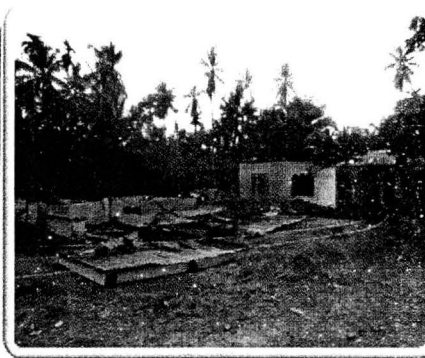
Puing – puing sisa kebakaran di Kecamatan Bahorok pada Maret 2013
