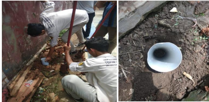
Gambar 4. Memperkuat Bagian Pinggir LRB
