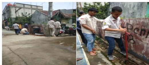
Gambar 3. Penentuan Lokasi LRB dan Pembuatan LRB
